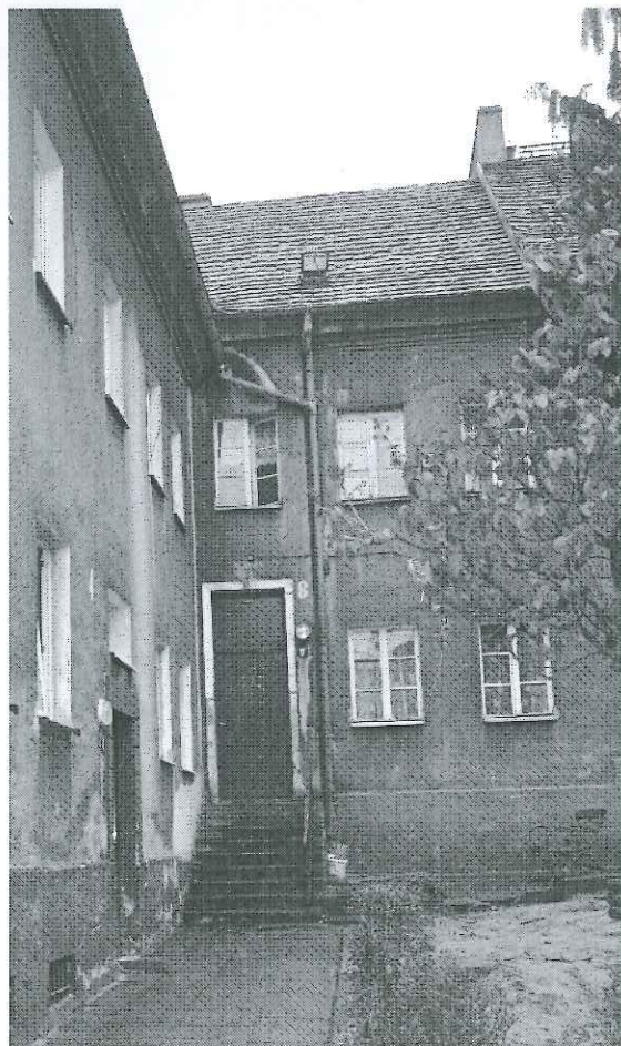
Elewacja od podwórza – wejście główne do budynku
