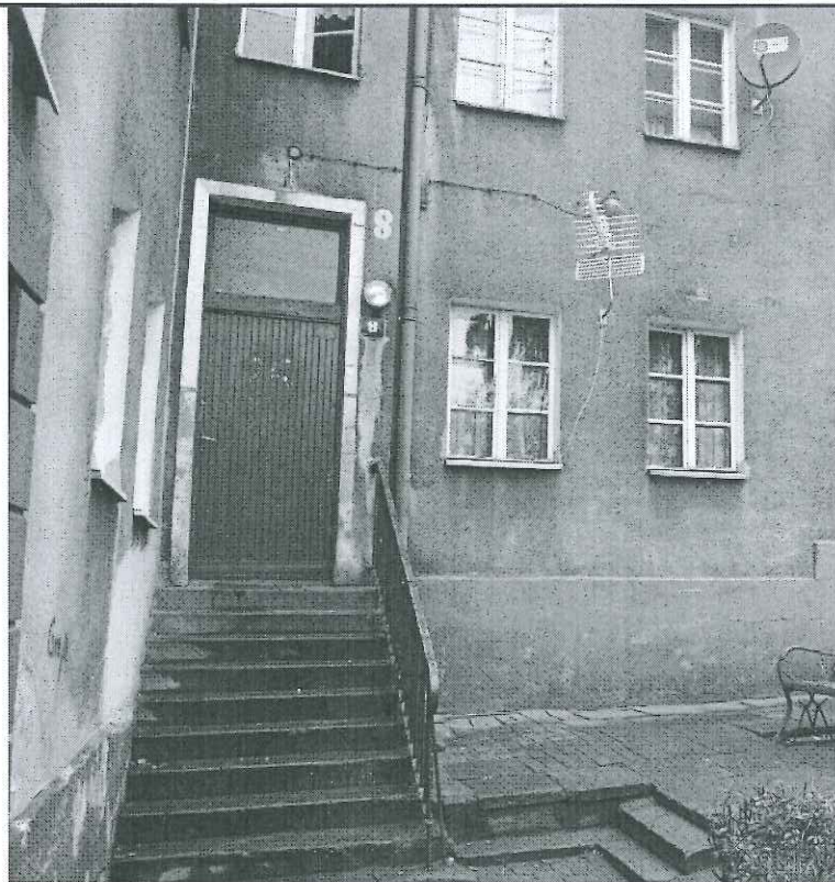
Elewacja od podwórka
