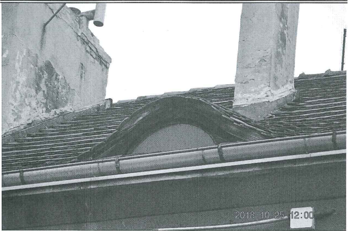
Detal okna „wół oko” i kominów.
