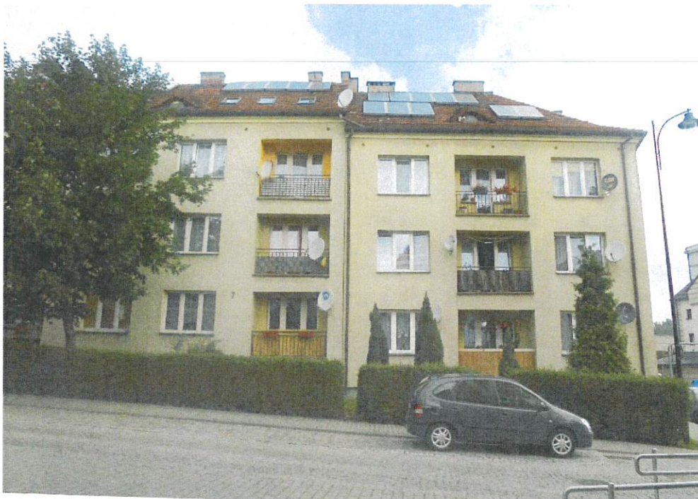
Widok elewacji od ul. M. Piłsudskiego 3-9
