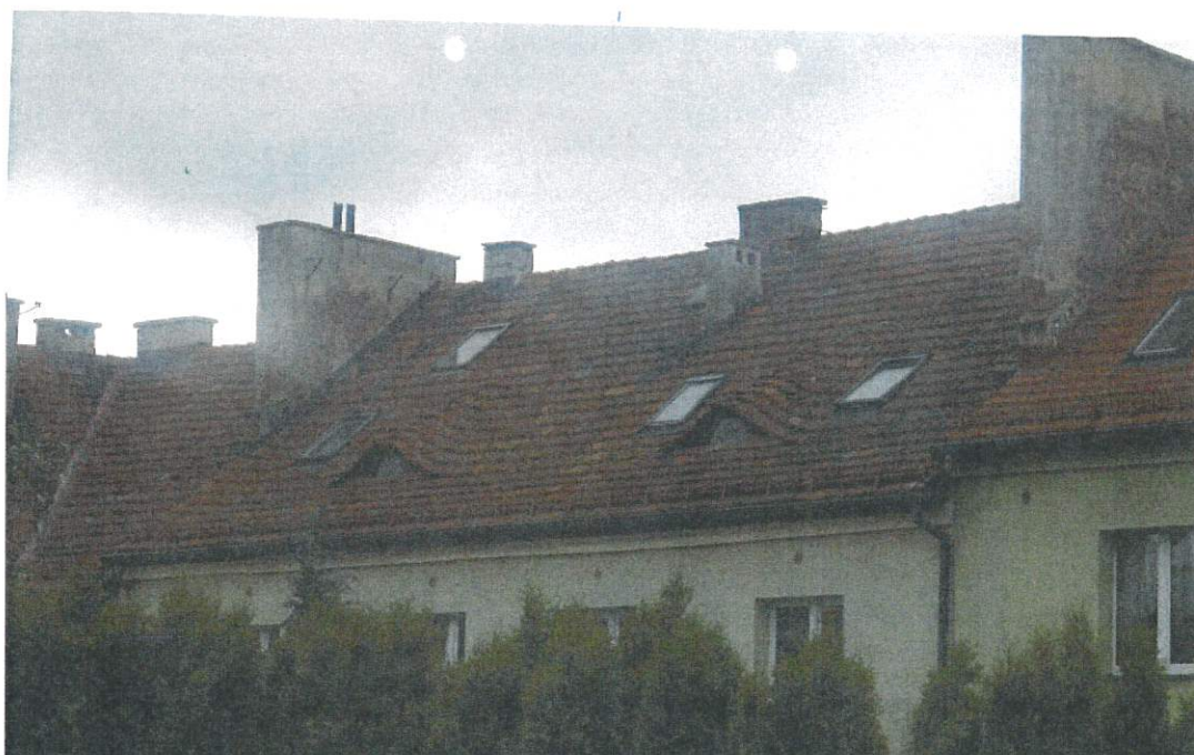
Widok dachu - ul. Marszałka J. Piłsudskiego 3 i 7
