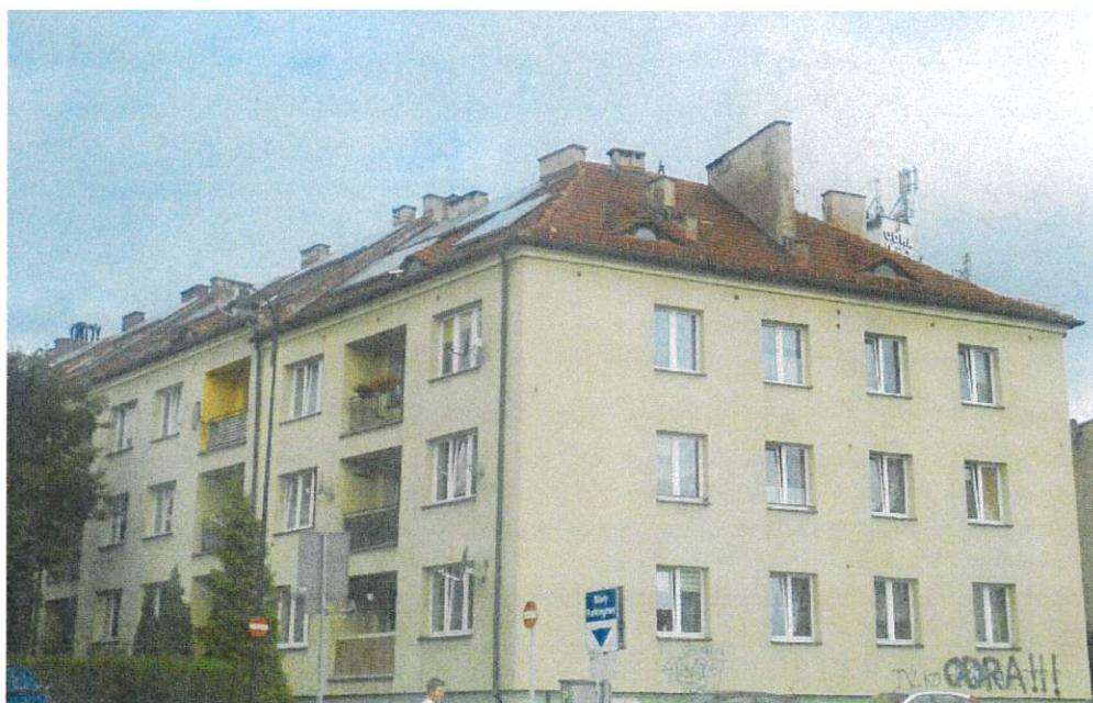
Elewacja od ul. Marszałka Piłsudskiego
