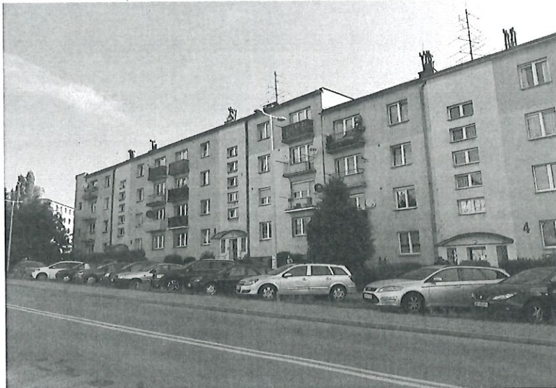
FOT. 10. Widok elewacji frontowej, tj. od strony południowo - zachodniej
