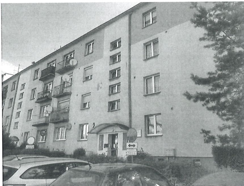
FOT. 6. Widok elewacji budynku od ulicy Harcerskiej, od strony południowo - zachodniej
