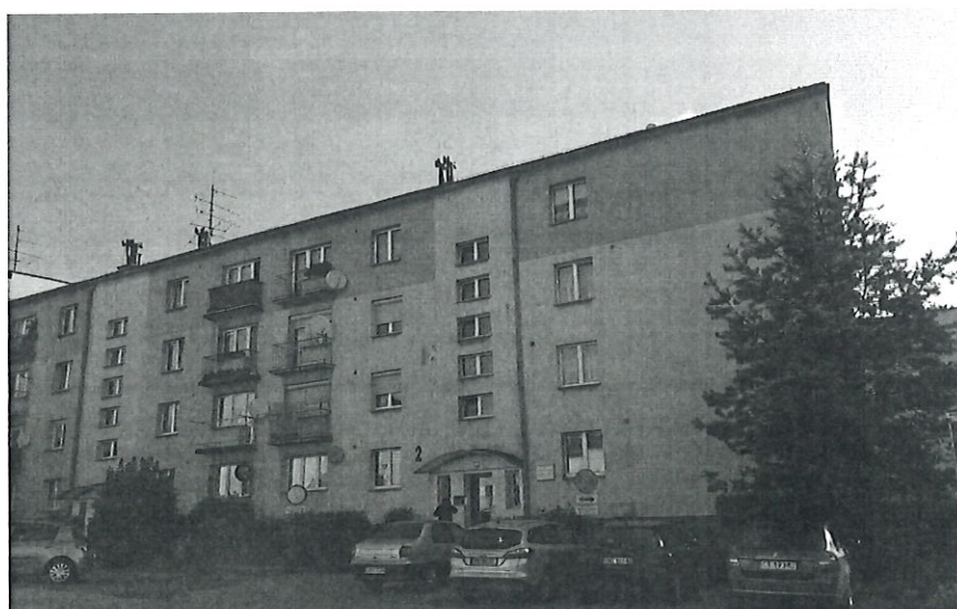
FOT. 9. Widok elewacji frontowej, tj. od strony południowo - zachodniej
