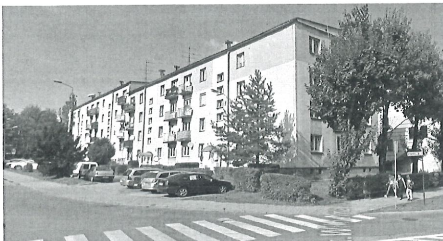
FOT. 11. Widok budynku od strony południowo – zachodniej – skrzyżowanie ulic Harcerskiej i Kubsza
