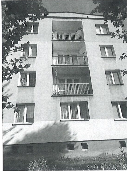
FOT. 12. Widok na ścianę szczytową od strony południowo - wschodniej
