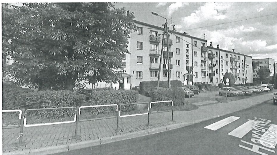
FOT. 1. Widok budynku od strony ulicy 26 Marca Źródło: https://www.google.com/maps
